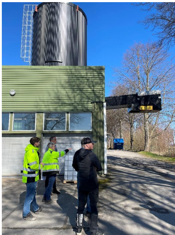
Figur 1. Slamsilo och slamutlastning, där utlastningsband med tipplucka syns till höger i bild.
