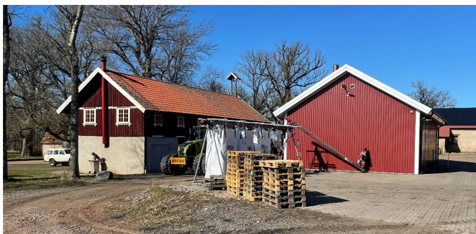
Figur 6. Fotografi över biokolsutmatning i storsäck vid Brachio-anläggning där biokol produceras från träflis (själva pyrolyspannan står inne i byggnaden till höger).
