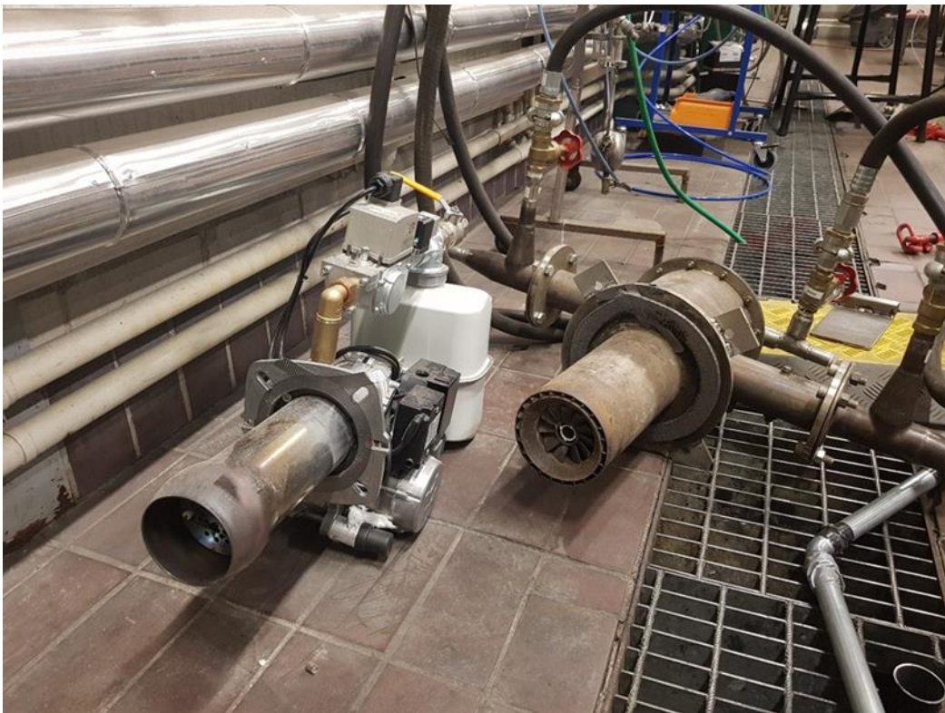
Figur 6 Vänster, gasolbrännare Bentone BFG 1 H3. Höger, träpulverbrännare WTS.
